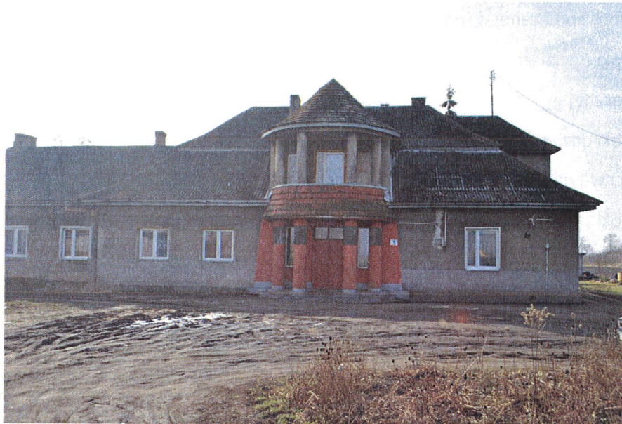
Fotografia 8. Dwór w miejscowości Plebanka.
