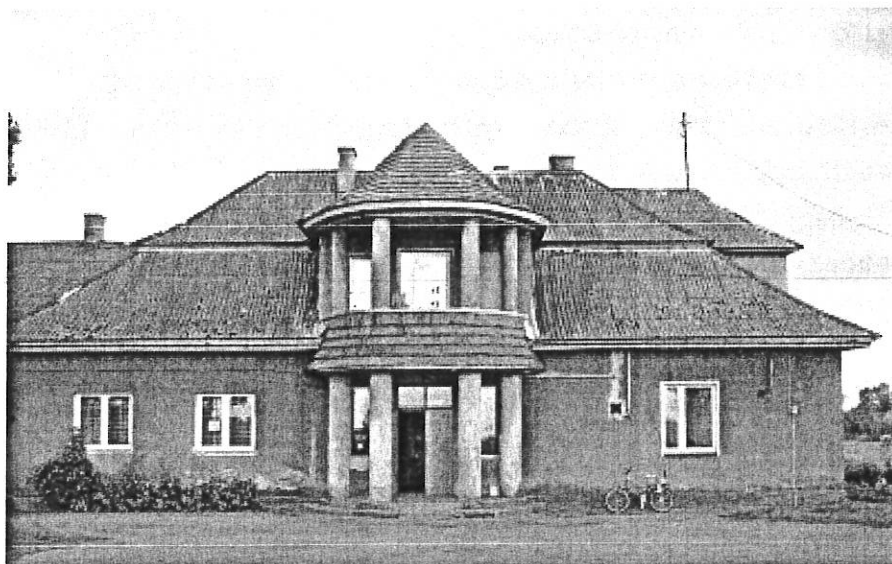
Fotografia 8. Dwór w miejscowości Plebanka.
