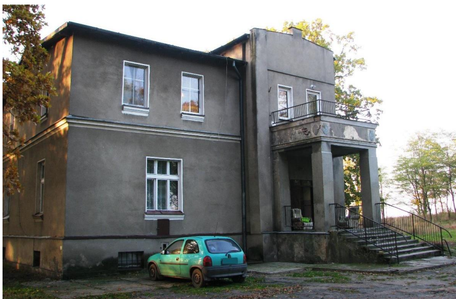
Fotografia 5. Dwór w Zdunach – 2015 rok.
