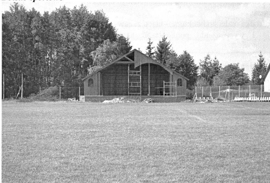
Budowa auli widowiskowej
